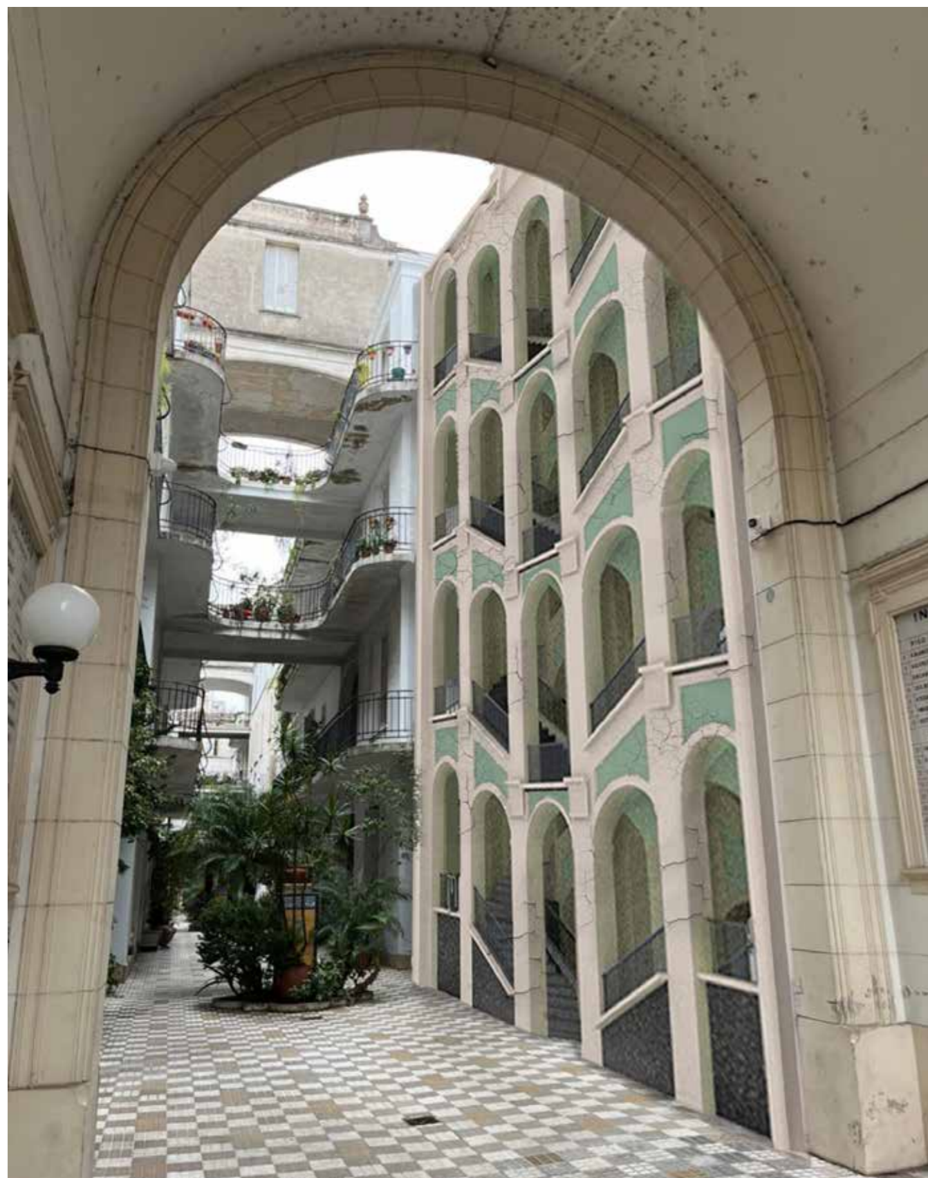
Fig. 7 - ampos 2022. Scale aperte napoletane. Palazzo dello Spagnuolo. Pasaje General Paz, Buenos Aires.
