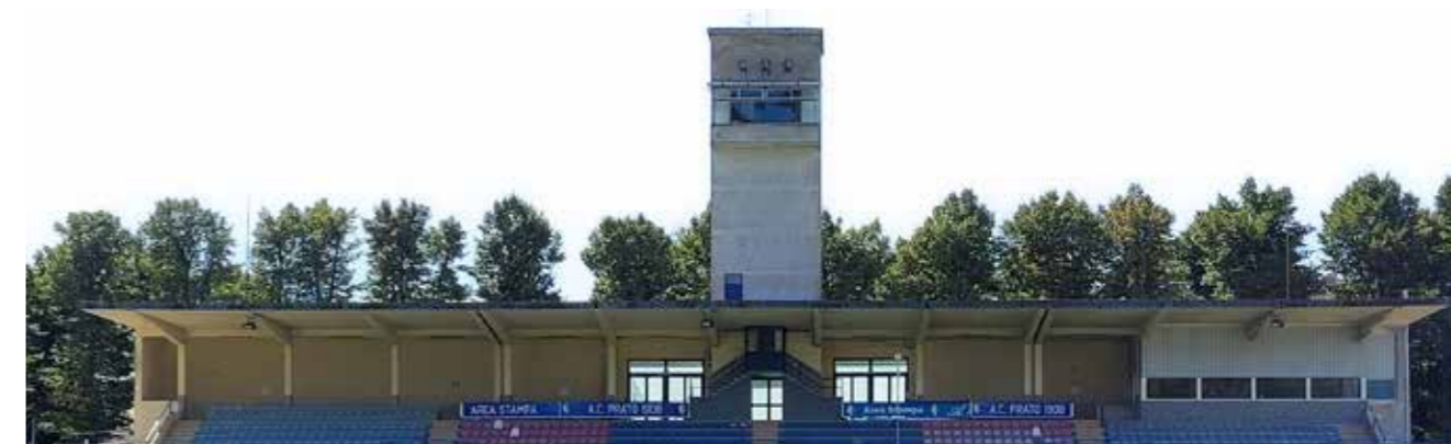
Fig. 2 - La tribuna centrale dello Stadio Lungobisenzio di Prato, Italia.
