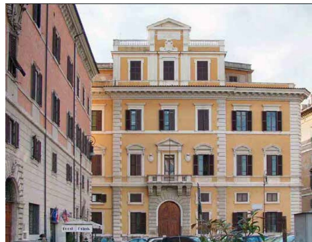
Fig. 2 - Edificio sito a Roma in piazza Fontanella Borghese, sede della facoltà di Architettura, Dipartimento di Storia, Disegno e Restauro. L'edificio si configura di elevato valore storico e documentale con una complessità costruttiva stratificata nel tempo. Nato come dipendenza del vicino Palazzo Borghese, fu inizialmente sede della facoltà di Economia e Commercio di Università degli studi di Roma La Sapienza [Bardati, 2006].
