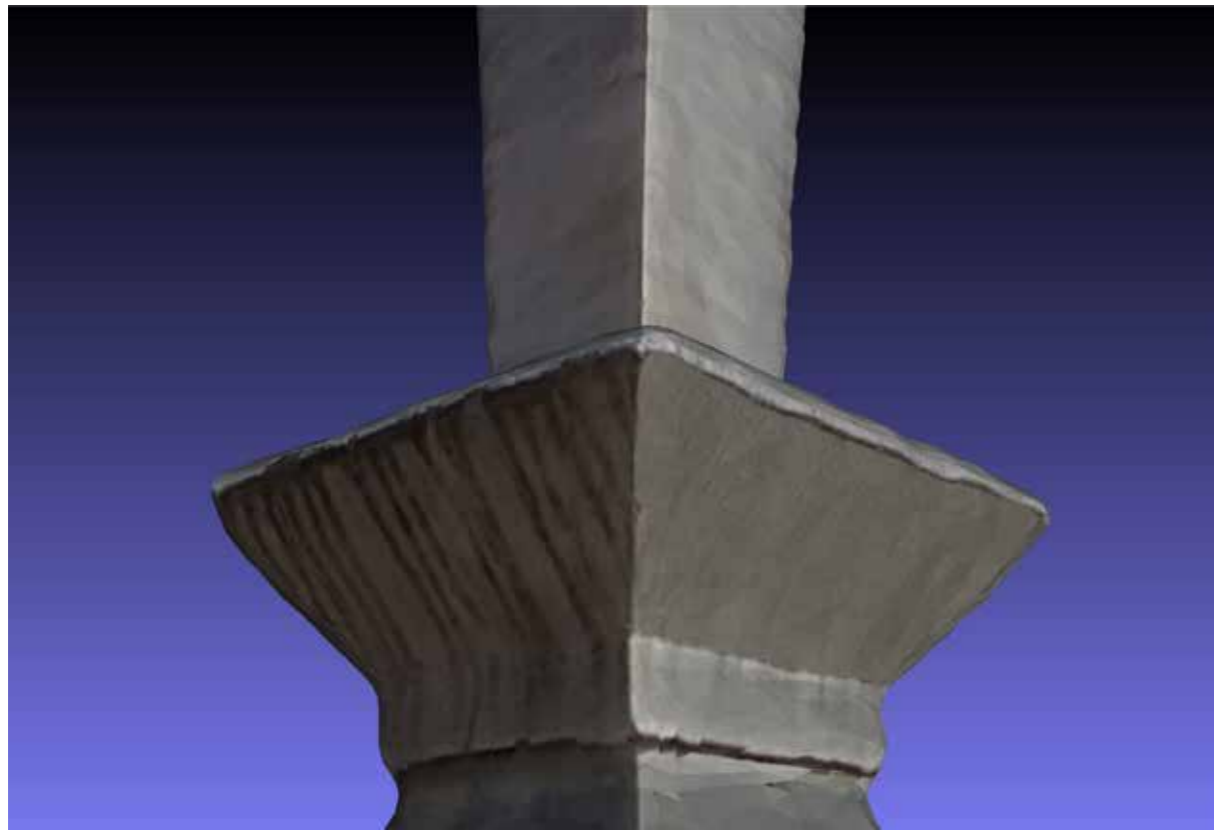
Fig. 6 - Detalle de las zonas con y sin intervención en su textura. Imagen de los autores.
