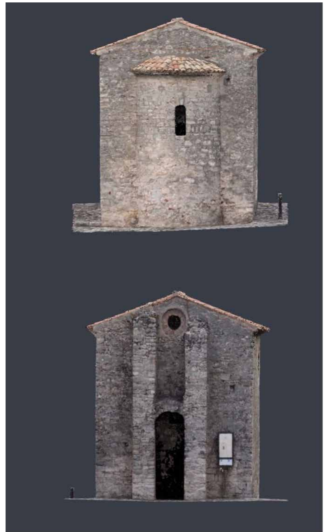
Fig. 2 - Pagina sinistra e destra: ortofoto della nuvola di punti della chiesa di San Giovannello. Prospetto sud, est, nord e ovest.
