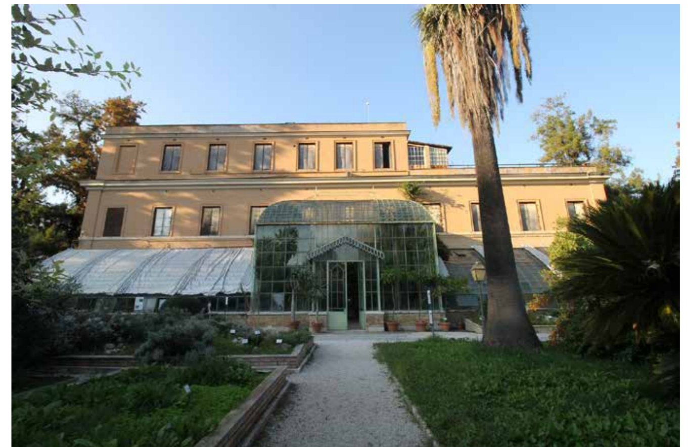
Fig. 4 - Palazzina Podesti sita a Roma nell'Orto Botanico. Realizzata nel 1889 ad opera di Giulio Podesti, ha subito alcune trasformazioni, tra cui l'aggiunta di una serra davanti al prospetto sud (1930) e la costruzione dell'aranciera (1930) [Borsellino, 1996; Bruno, 2013].
