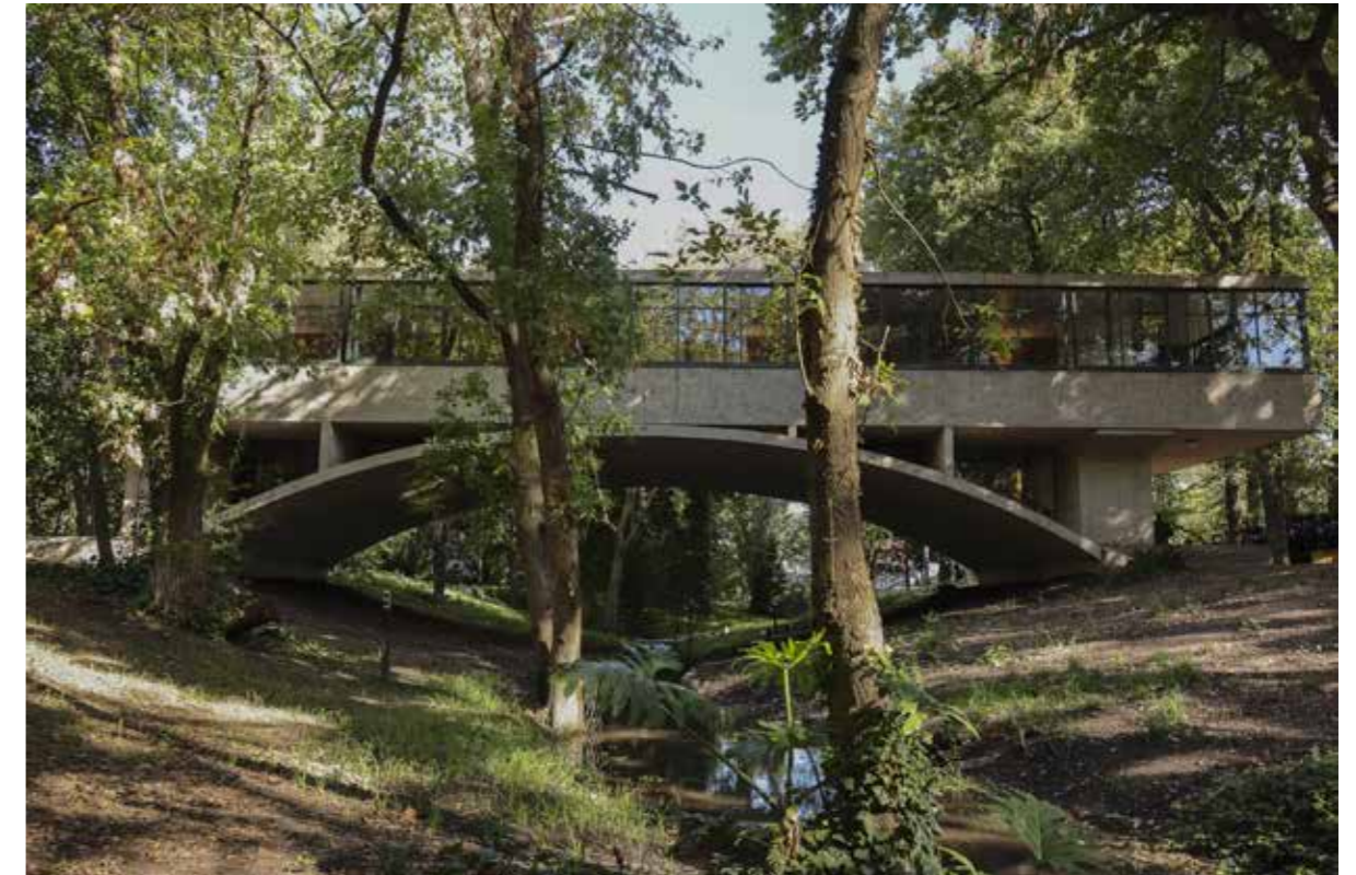
Fig. 14 - vista del edificio desde el exterior tras la restauración.
