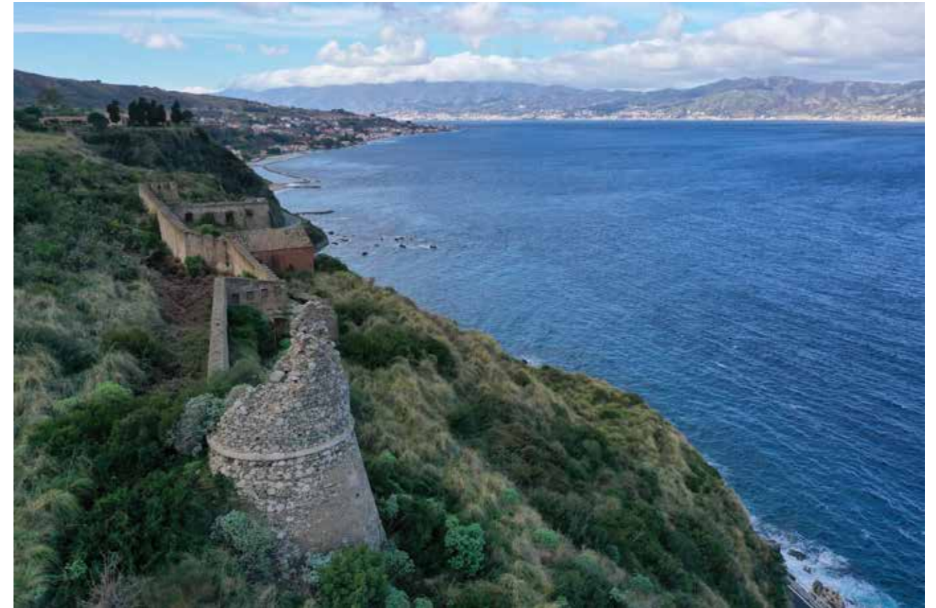
Fig. 1 - Torre Cavallo, Villa San Giovanni, Stretto di Messina.
